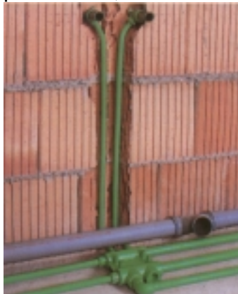
Slika 7. Podžbukno postavljanje cijevi [3]
