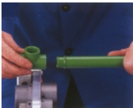
Slika 5. Zavarivanje PP-R cijevi; 2 Zagrijani dijelovi prije spajanja [3]
