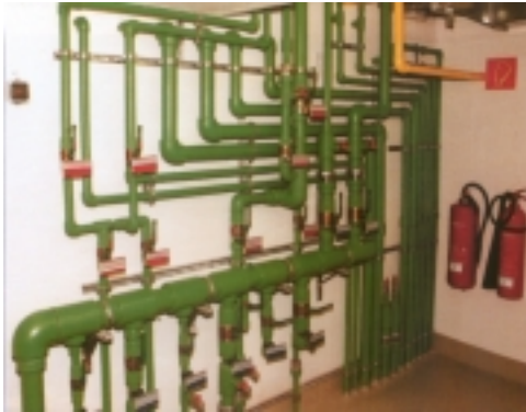
Slika 8. Nadžbukno postavljanje cijevi [3]
